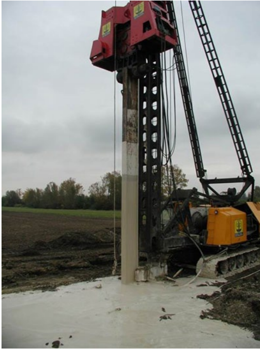
■ Abb. 8.3 Errichtung einer Schmalwand
